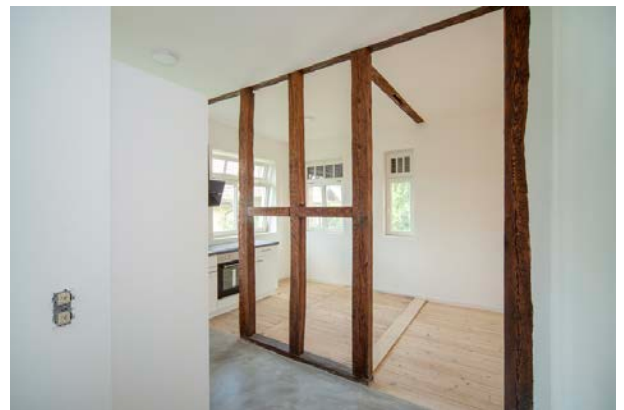
Alte Balken, Bodenbeläge und Türen wurden aufgefrischt bzw. mit Naturöl neu versiegelt.
